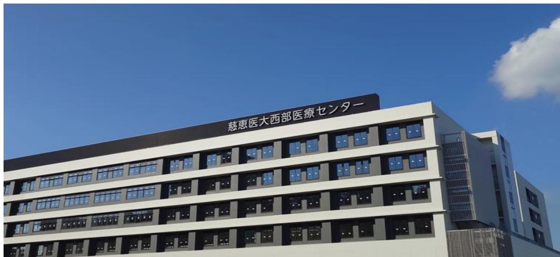
竣工した「(仮称)東京慈恵会医科大学西部医療センター」の新本館棟
