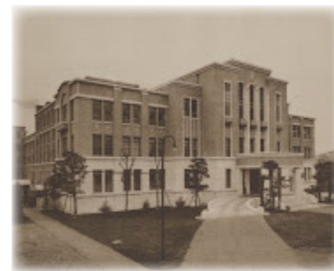
【震災から7年後】昭和5年 東京慈恵会医院竣工
