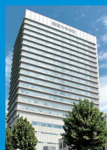
附属病院(本院)中央棟
